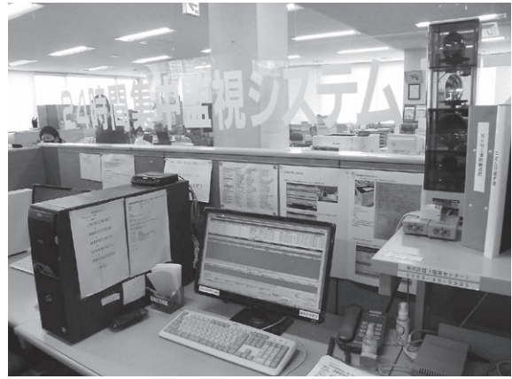
24時間集中監視システム
